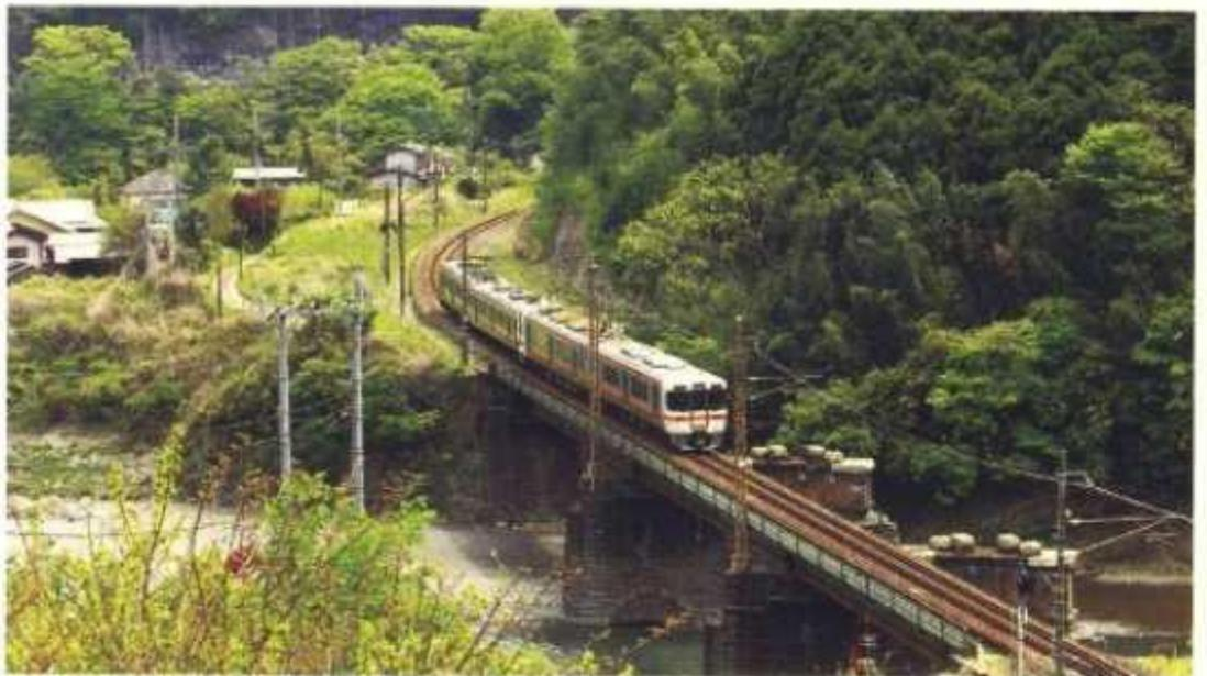
JR御殿場線の山北・谷峨間を走る列車。鉄橋の橋脚に複線だった時代の面影が残っている。昭和43年に全線電化するまではD52型蒸気機関車が活躍した。
